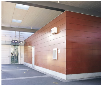
Einfache Holzkuben gruppieren sich unter einem schwebenden Holzdach auf einem massiven Stahlrahmen.
