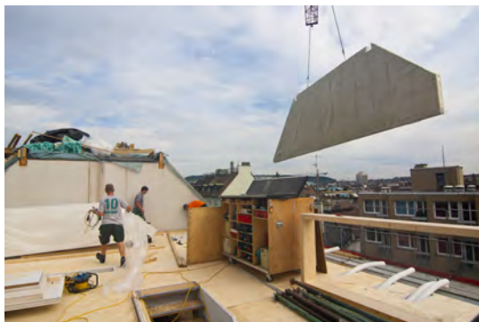
Einbringen der Wandelemente der Aufstockung
