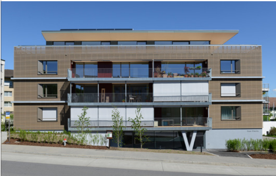
Südfassade nach der Sanierung
