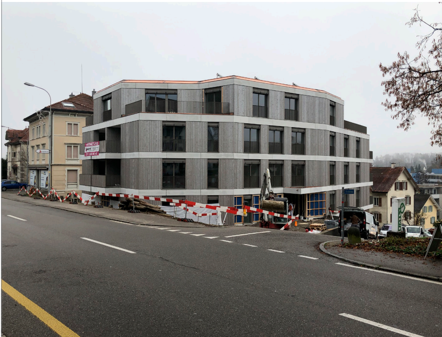
Baustelle von Westen Anfang November 2018
