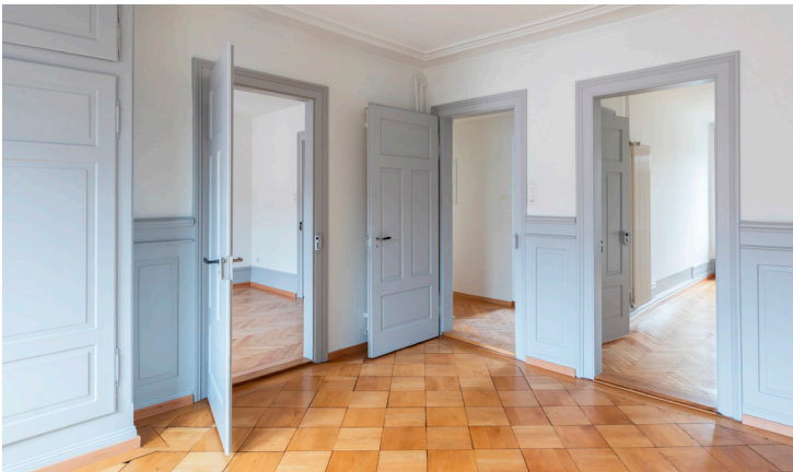
Aufarbeitung und Instandsetzung der erhaltenen Boden- und Wandbeläge
