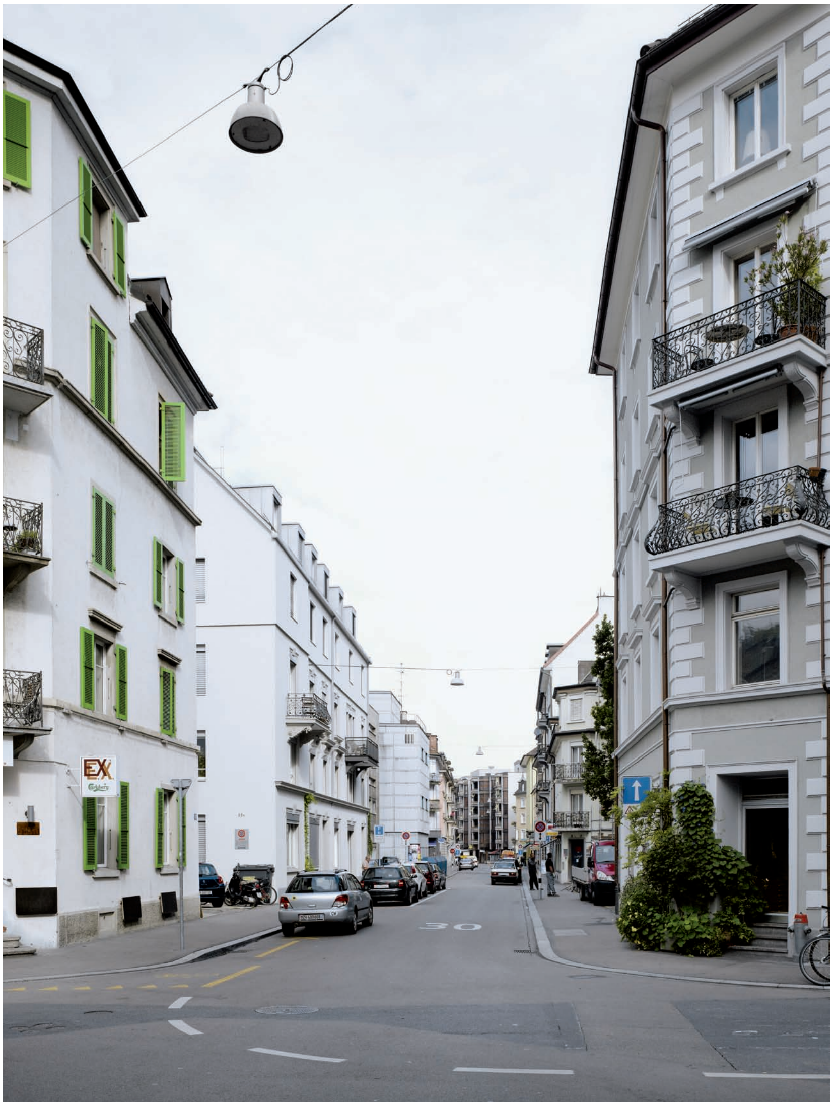
^ Jugendwohnhaus im Kreis 4: Aus dem Rotlicht-Einzelzimmerhaus wurden wieder Wohnungen – samt Aufstockung. < Früher grau, heute grün: Hochhäuser Sihlweid in Zürich-Leimbach mit ihren neuen Solarfassaden.
