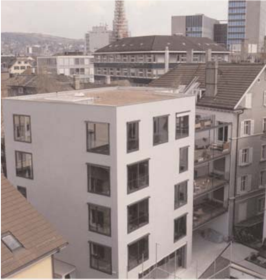
Neu und Alt treffen sich bei der Häusergruppe der Genossenschaft Dreieck, die unweit vom Zürcher Stauffacher liegt. Im Bildzentrum der Neubau Gartenhofstrasse.
